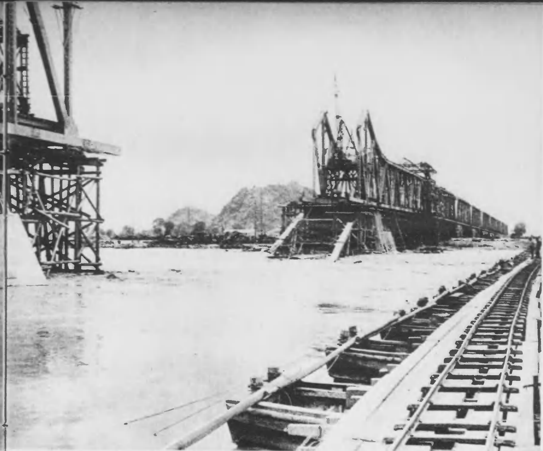
大陸日本建設には凡ゆる困難を克服し て進まねばならない。黄河大橋の修理 は建設戦の第一着手として、本年一月末 工事第一班到着以來、わが土木建築界の 全智全能力をあげて開始された。
