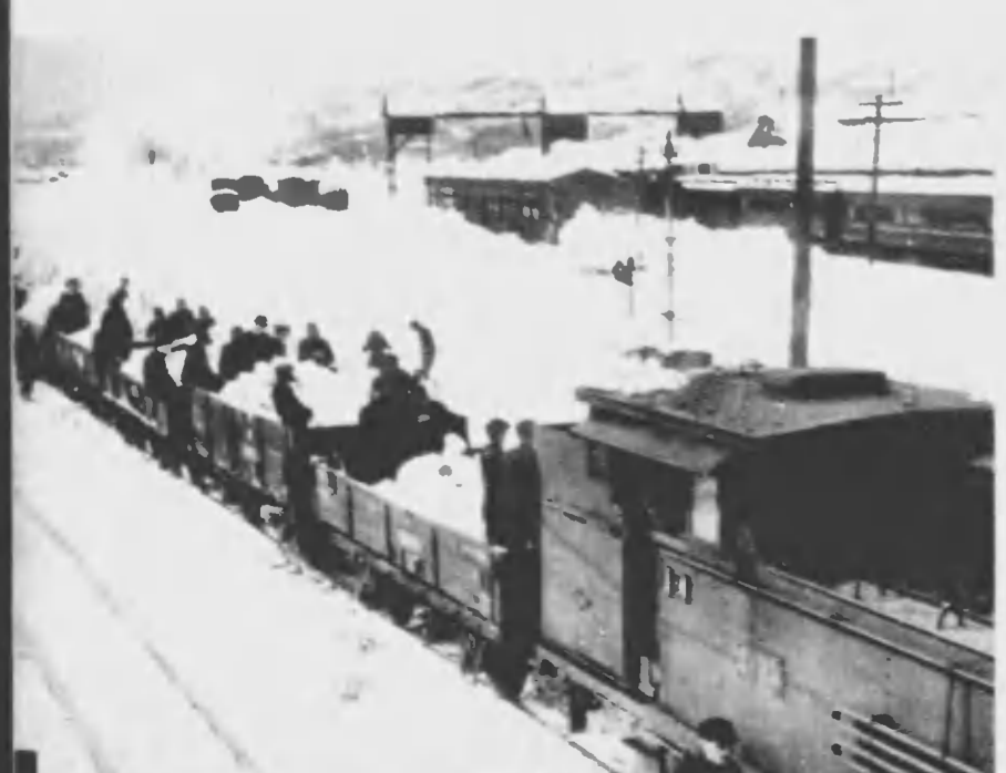
崖下を縫ふ軌道はなだれの恐れもあり、吹溜りもはげしい。かろいふところは俗に魔の場所と呼ばれ、吹雪やなだれを防ぐためには防雪林が設けられてある。積雪四米にも達したその軌道の除雪には、マクレー（車手前）とロータリー（車前方）が併用されてゐる。 町や村の青年團、在郷軍人、除雪組合員等出動、國鐵の除雪に協力する。毎年百萬人を動員される除雪人夫が、今年一月末で既に四十六萬人に達した。 雪捨列車。操車場や構内に後から降り積む雪の川は普通十餘位連結した無蓋車で、附近の川や築堤に捨てる。
