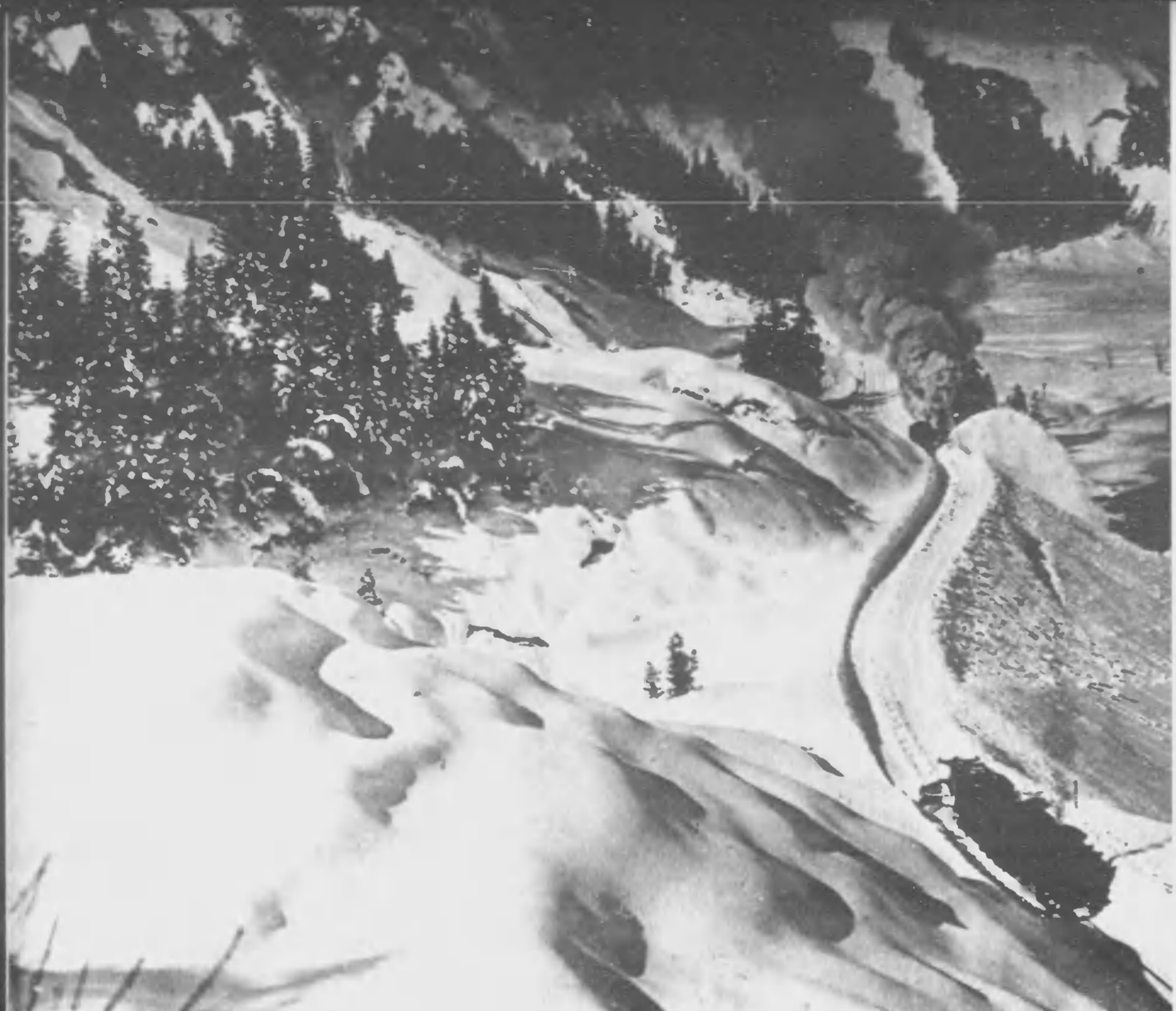
崖下を縫ふ軌道はなだれの恐れもあり、吹溜りもはげしい。かろいふところは俗に魔の場所と呼ばれ、吹雪やなだれを防ぐためには防雪林が設けられてある。積雪四米にも達したその軌道の除雪には、マクレー（車手前）とロータリー（車前方）が併用されてゐる。 町や村の青年團、在郷軍人、除雪組合員等出動、國鐵の除雪に協力する。毎年百萬人を動員される除雪人夫が、今年一月末で既に四十六萬人に達した。 雪捨列車。操車場や構内に後から降り積む雪の川は普通十餘位連結した無蓋車で、附近の川や築堤に捨てる。
