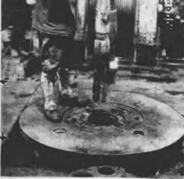
循環泥水機 循環用泥水はロータリー式鑿井の生命であつて、その物理的性質 例へば粘度や比重とか含砂率等の適當な調整によつて坑壁崩壞の防止や掘り易いために最も重要なものである。掘削の開始 この地下にはきつと油層があるぞ！四羽ビートを掘管の先端につけて、これから掘削が始まる
