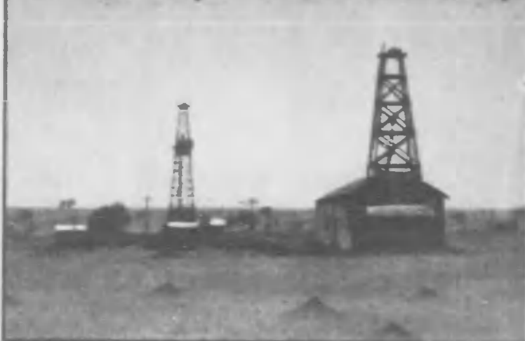
カブトは東岡々營子試掘場の全景。左は「満洲石油あり」の旗歌を上げた採掘の塔、ロータリー式一號井、右は「式二號井」
