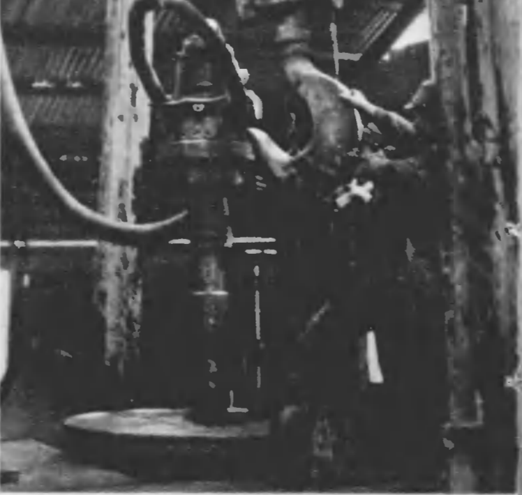
掘削作業 坑内上方から吊下つた掘管昇降用の四車フックとフックの作業。左側のホースは掘泥水を循環用のロータリー・ホース。ラックで製油場へ運ばれる
