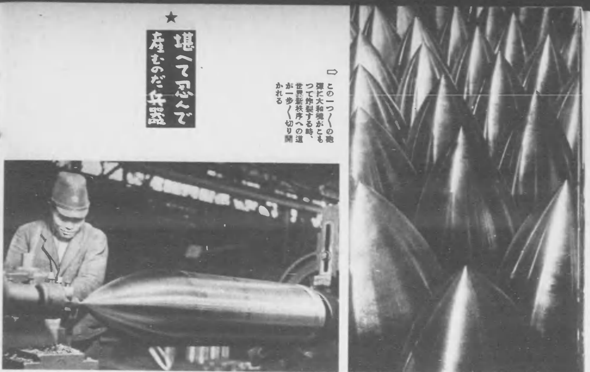
早い速度で旋廻し ながら徹甲弾の一 外面削り。流線型 の美しい姿が大き な弾を畫いて着弾 を減つて飛ぶ日が 目に浮かぶ
