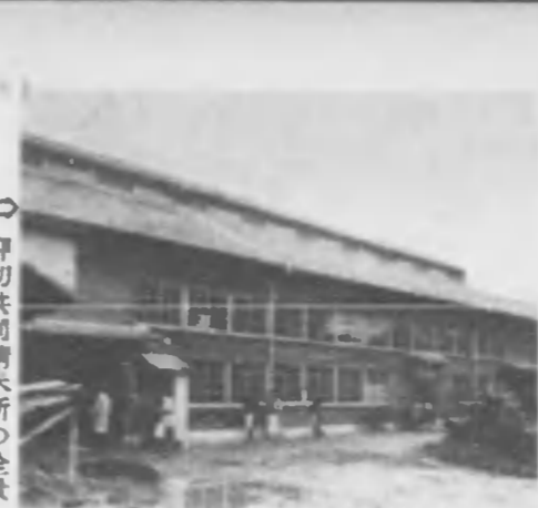
押切共同精米所の全貌
