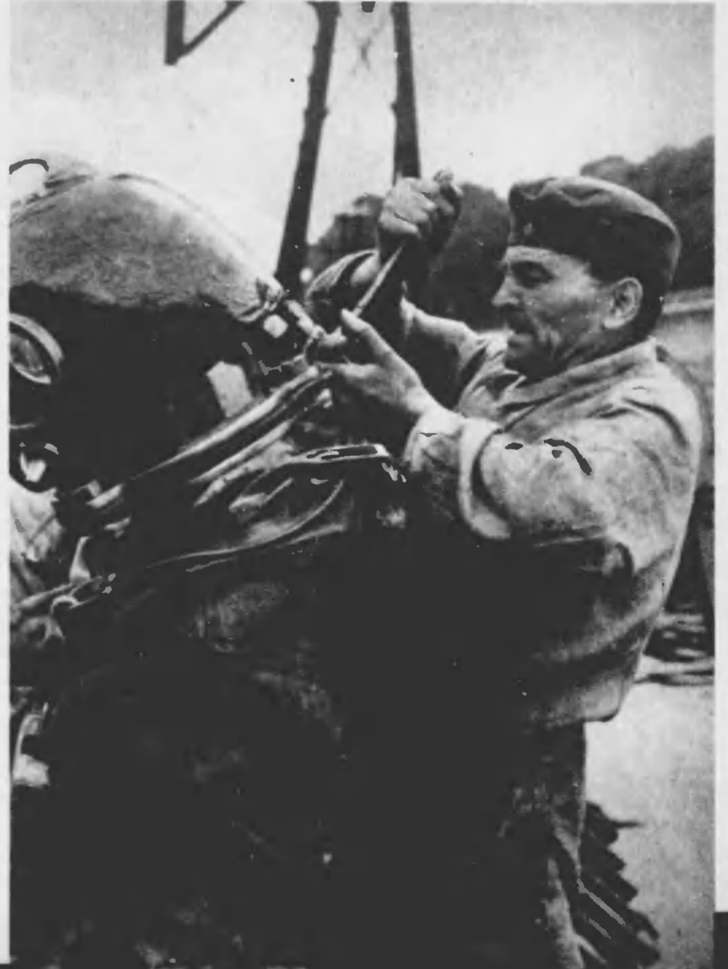
⇒ 橋脚の破損箇所の調査に技術者は潜水服を着て水中にもぐる
