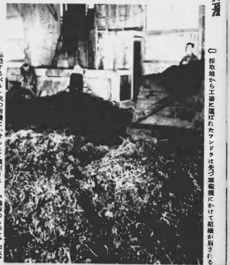
振動するベルト状の機械にかけられて選別される。こゝでは機械の手で不純物が草草とりのぞかれ長繊維、中繊維、短繊維に分けられ、それぞれ用途によつて次の加工に廻される。――製粉作業
