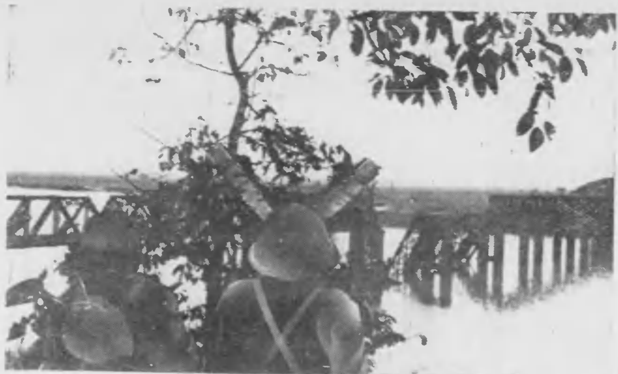
無様に破壊されたシタン河橋
