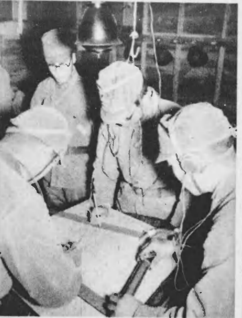
計算班は防空隊の頭腦。聴音機が敵機を捉へると、寸秒の間に位置、高度、速度 等の諸元が割出される。従つて表の上にある姿の見えない敵機でも射撃ができる
