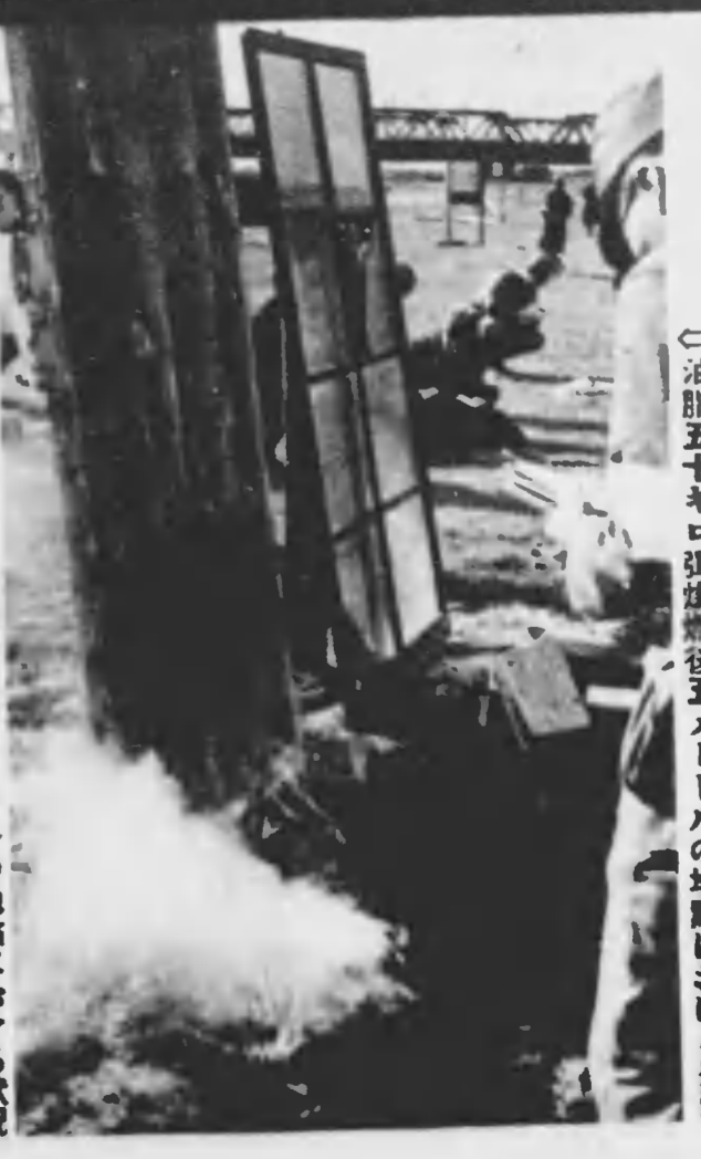
油脂五十キロ弾爆発後十メートルの地点における状況
