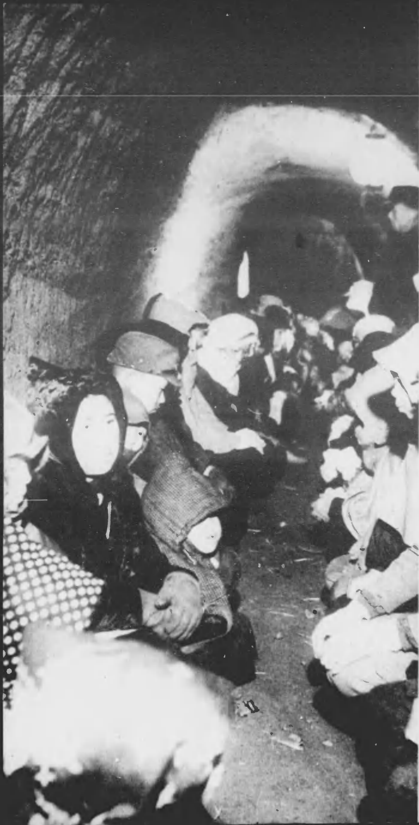
内部は寒冽、馬蹄型に掘られてゐる。土質を上げれば支保工はなくても大丈夫 空気が、空気がこれで自然に換氣される
