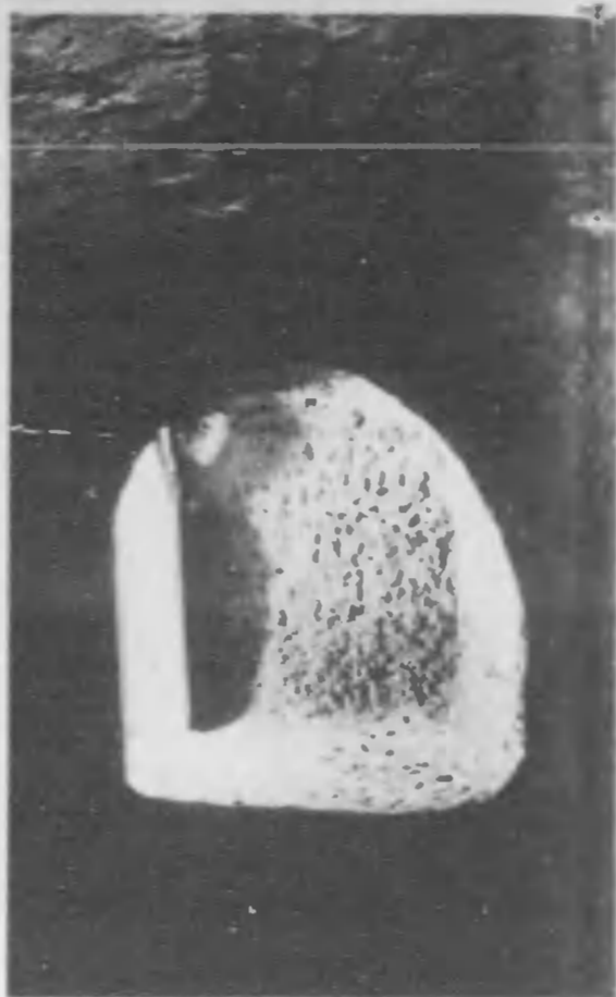
内部は寒冽、馬蹄型に掘られてゐる。土質を上げれば支保工はなくても大丈夫 空気が、空気がこれで自然に換氣される
