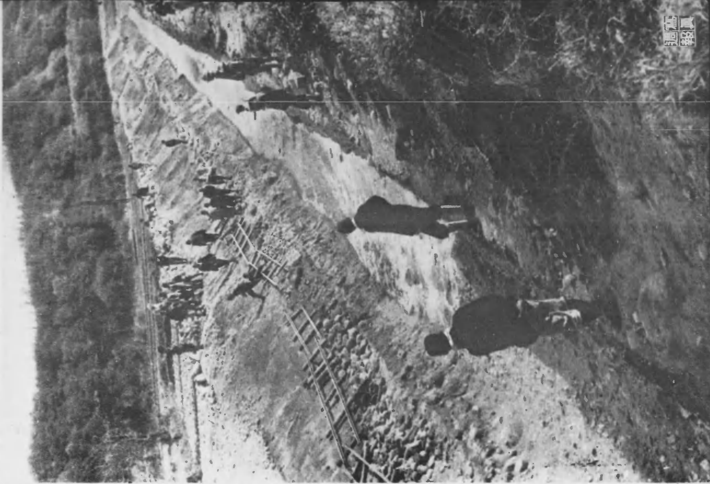
新しい導水路の底を覆つた水先が流る。導水路は突貫工事では重宝と、この以外にはコンクリートを伸ばさず、みな土製で間に合はせてゐる。田圃から注ぎ入る水が、新開田地深持に満ちてゆくと、お百姓さんにはもう切れ切れ、通水のその日、深持の人びと、代掻きに新田の肥水を勤むよくはね上げた。
