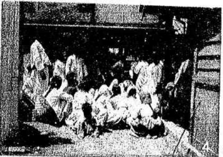
(3) 全羅南道慈惠醫院修繕後落成ノ狀況 (4) 慶尙北道慈惠醫院患者待合ノ狀況
