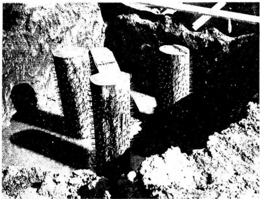
九二 棧橋基礎杭引拔試驗 大正六年十一月二十六日 棧橋之脚基礎杭引拔之釘釘 大正七年三月十八日
