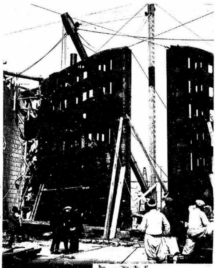
六二 兩門扉之組立 其九 大正六年四月二十日 六三 兩門扉之組立 其十 大正六年四月二十七日 六四 兩門扉之組立 其十一 大正六年五月二日 六五 兩門扉之組立 其十二 大正六年五月十一日
