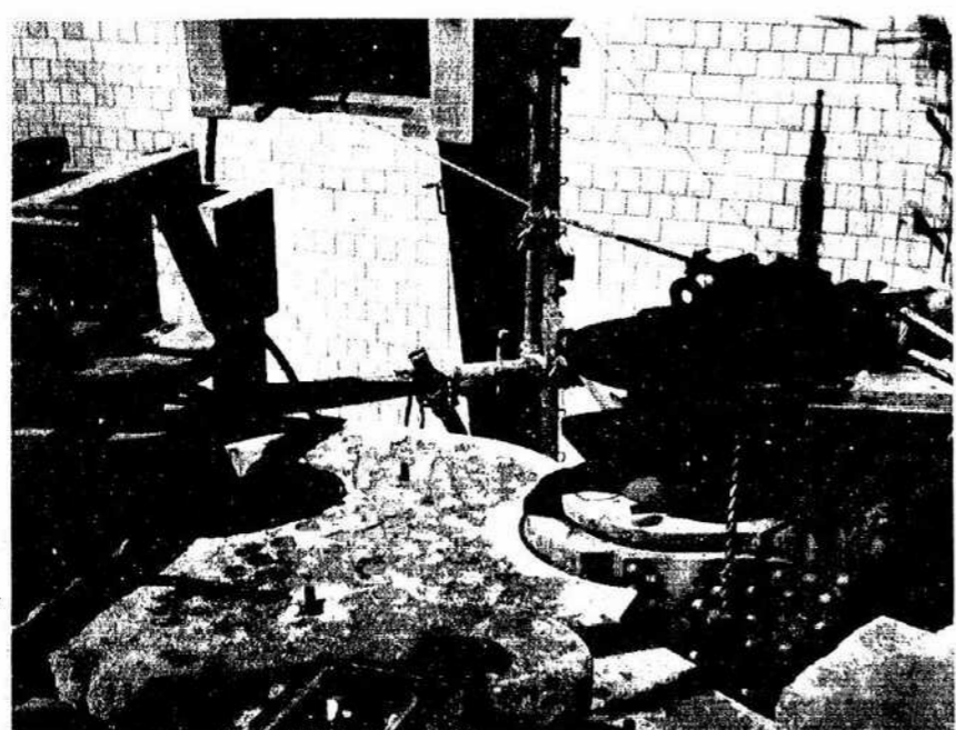
七六 上部アレン、コイル、之埋設 大正五年十一月二十四日 七七 取付前ニ於ケルアレンコイル及ヒール、ポスト 大正六年八月十一日 七八 アレンコイル及ヒール、ポスト之取付 大正六年十一月二十七日
