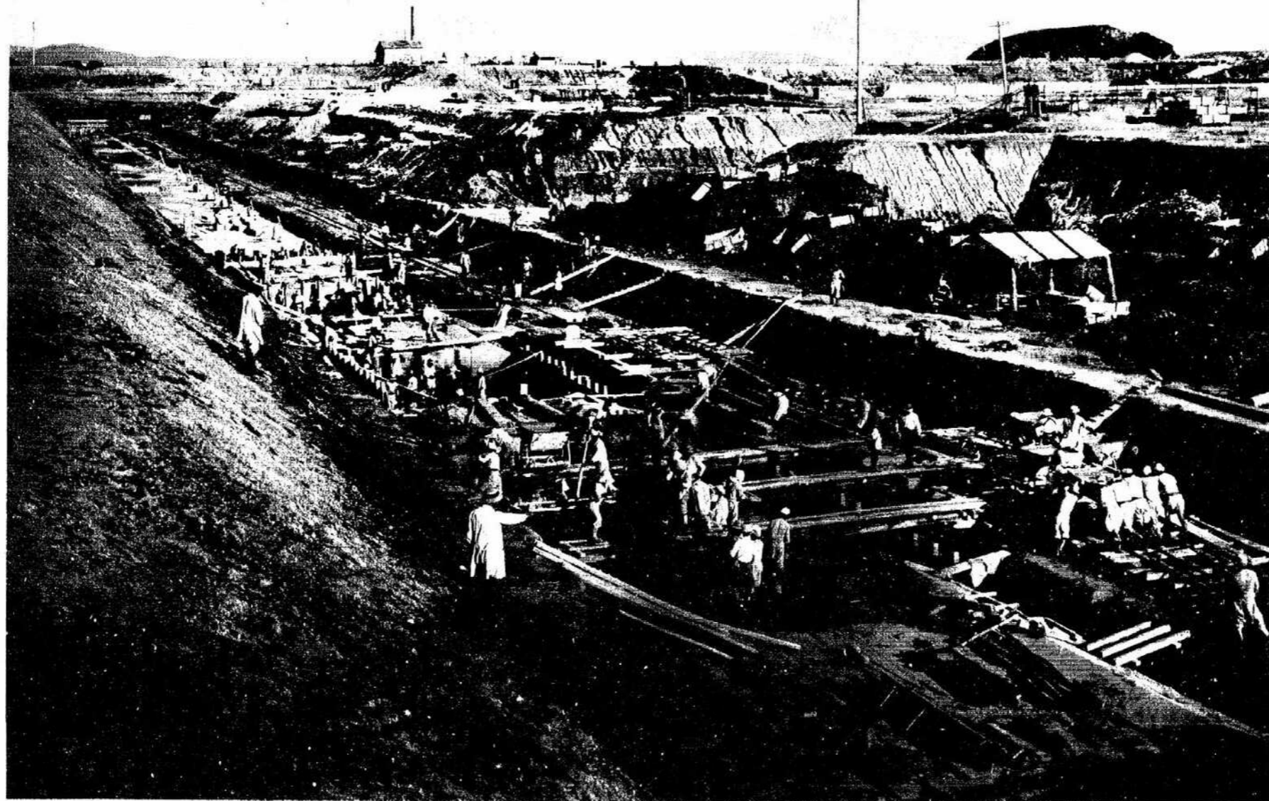
三六 築船塢基礎混凝土之施工 大正三年八月十一日
