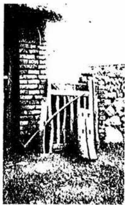
第 6 圖 農家ノ豚舎 (密雲縣 壇營村) 本屋ト土塼ヲ利用シテ造ツタモノ デコノ豚舎ノ前ハ土質堆積場ニナ ツテキル、庭トノ界ニハ土塼ガア リ其取扱比較的良好ナルヲ見タリ
