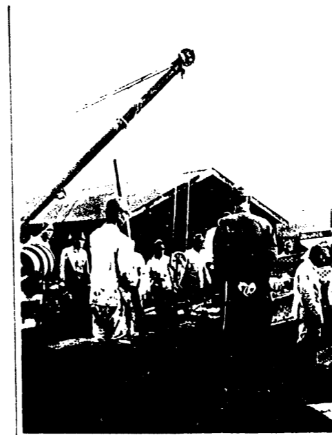
附圖第四 起重機=依ル架尾懸吊(懸吊作業中)
