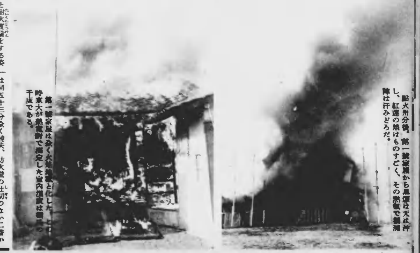
第一號、第二號 焼夷弾火の瞬間。天然色カメラが決定 露光を包圍保持してゐる。左の壁は焼網モル タル防火壁で降下のみを第二號家屋と仕切つ てゐる。
