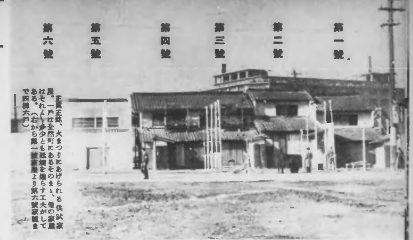
第一號、第二號 焼夷弾火の瞬間。天然色カメラが決定 露光を包圍保持してゐる。左の壁は焼網モル タル防火壁で降下のみを第二號家屋と仕切つ てゐる。
