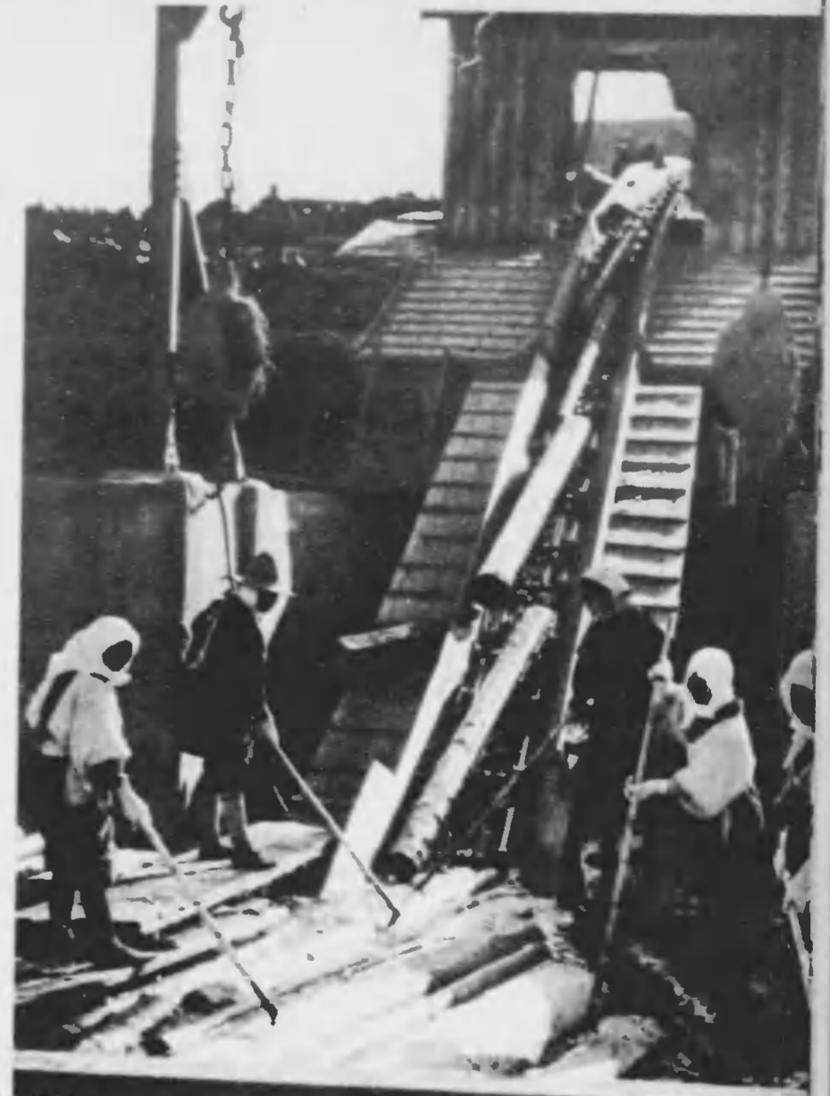
選木された丸太は川口からロツクホールにのつて貯木場へ。こゝで噴霧もろとも高でつみ上げられる。
