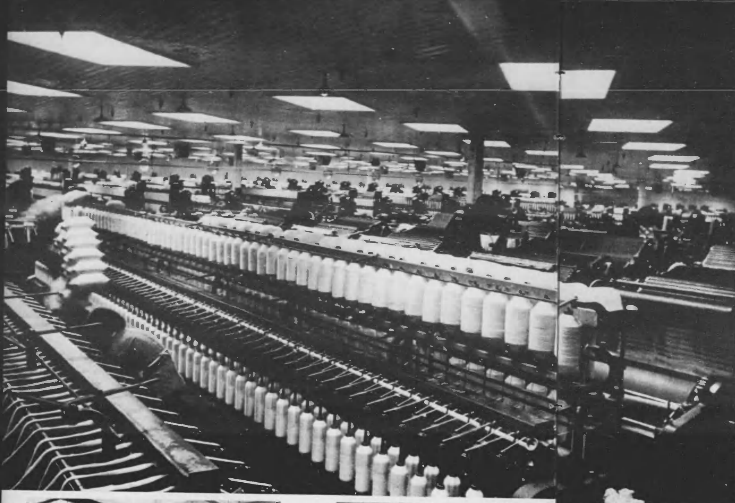
上海のわが東洋、上海南紡績工場は最新の設備を施し製糸に全機能をあげてゐる。見渡す工場は紡績機、繰紡機、精紡機が一齊に動いてゐる。
