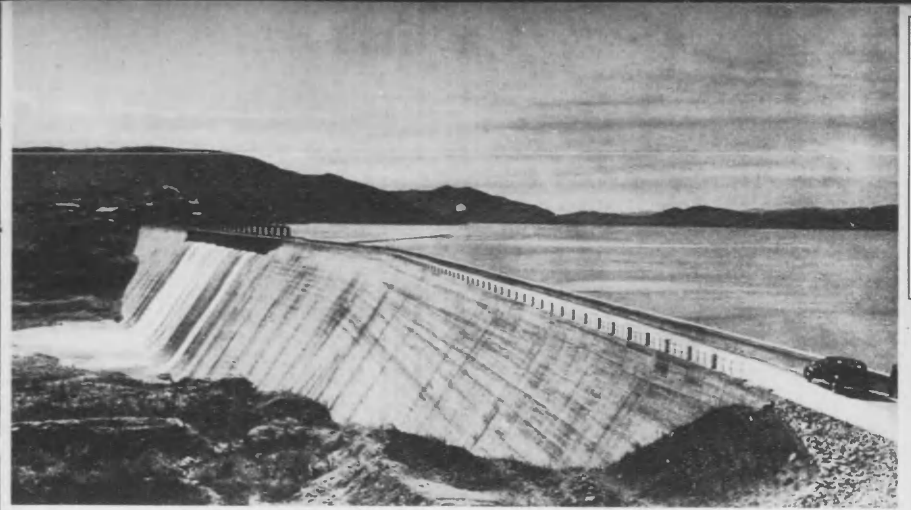
人工の湖水としてわが國第一と呼ばれる長津江水電貯水池は十億立方メートルに水を満々と湛えてゐる。この水を日本海側に導いて三十六萬キロの電力を得、あらゆる近代工業が勃興してゐる。
