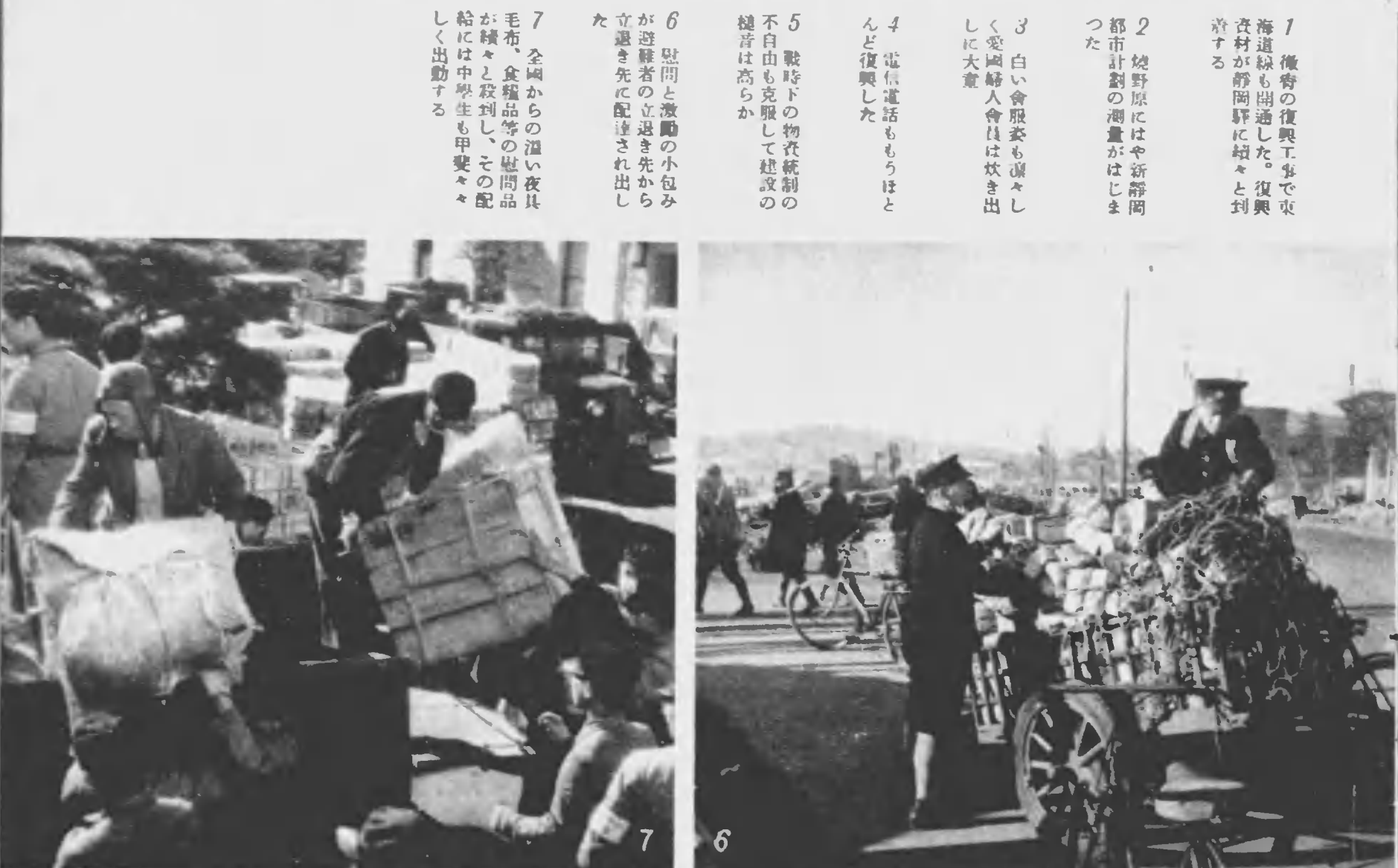
1 備前市の復興工事で東海道線も開通した。復興資材が静岡野に續々と到着する 2 焼野原にはや新静岡都市計劃の測量がはじまつた 3 白い會服姿も凛々しく愛國婦人會員は炊き出しに大奮 4 電信電話ももうほとんど復興した 5 戦時下の物資統制の不自由も克服して建設の機音は高らかに 6 慰問と激勵の小包みが避難者の立退き先から立退き先に配達され出した 7 全国からの温かい夜具毛布、食糧品等の慰問品が續々と殺到し、その配給には中學生も甲斐々々しく出勤する
