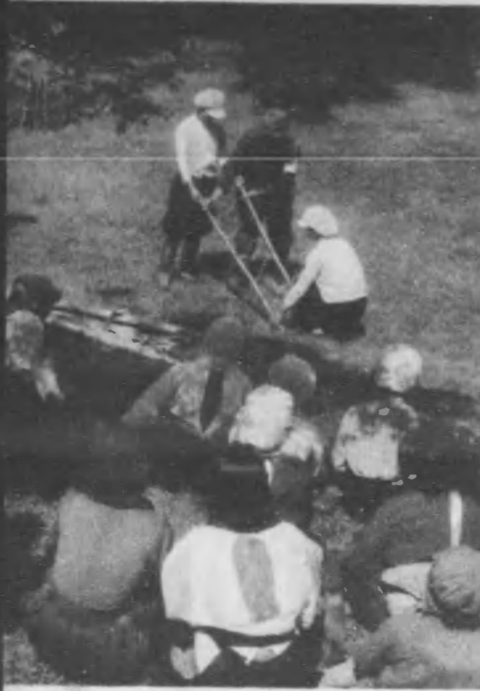
簡易煙幕、二本竹と六、七メートルの紐を用意しておけば、ほんの一、二分で手軽に出来上ります
