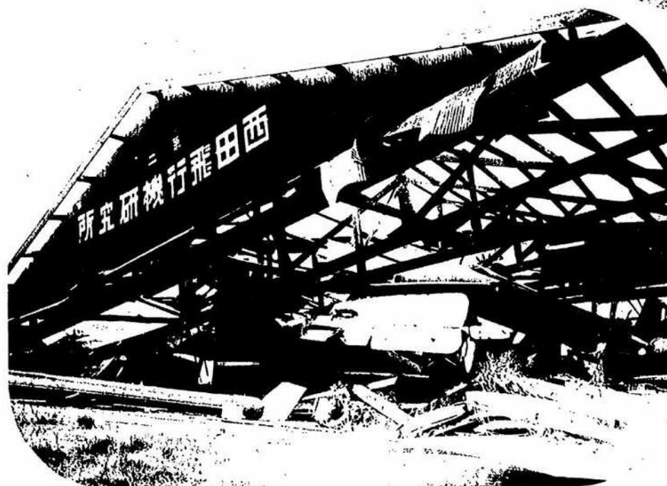
大阪府大正區第二西田飛行機研究 所ノ被害 格納庫 二棟 全壊 最高潮 五尺
