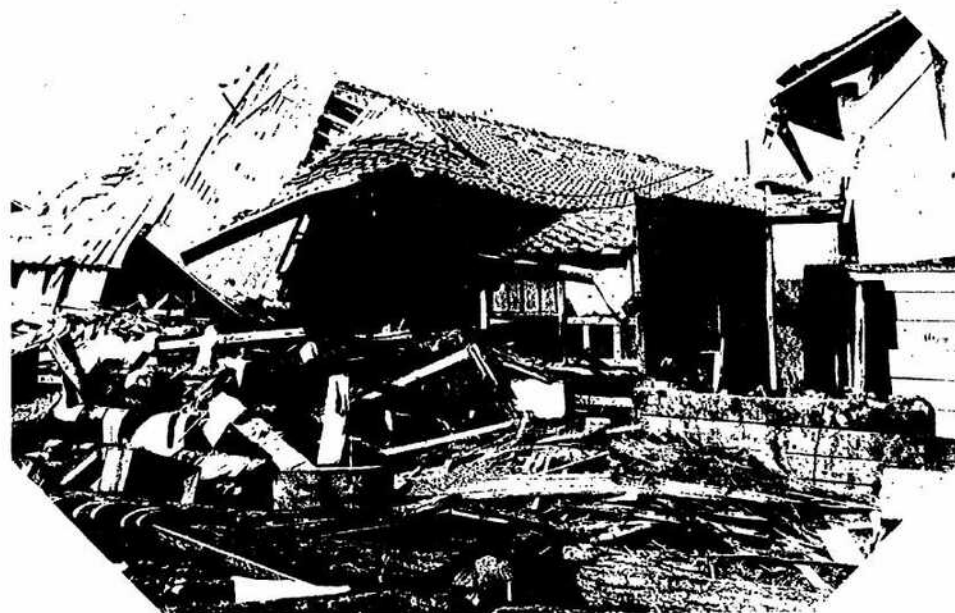
大阪府大正區鶴町濱ニ於ケル慘狀 此ノ附近ハ風水害最モ激甚ナリシ所 ニシテ平家住宅ハ浸水軒ヲ没セリ 最高潮 七尺乃至八尺
