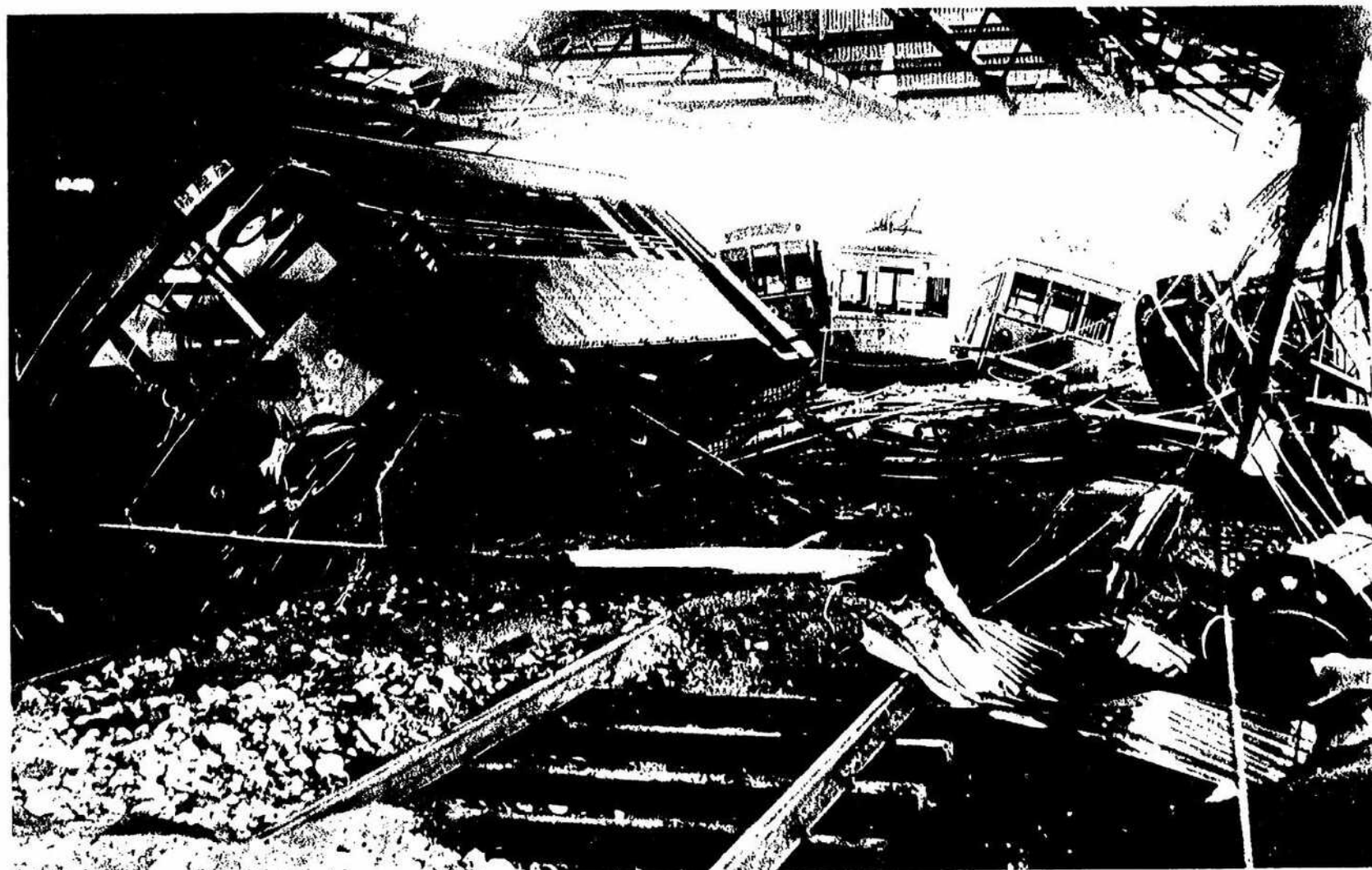
埋立陽塚電線会館中月内、 電車、被害 最高潮、上層乃至上二尺餘
