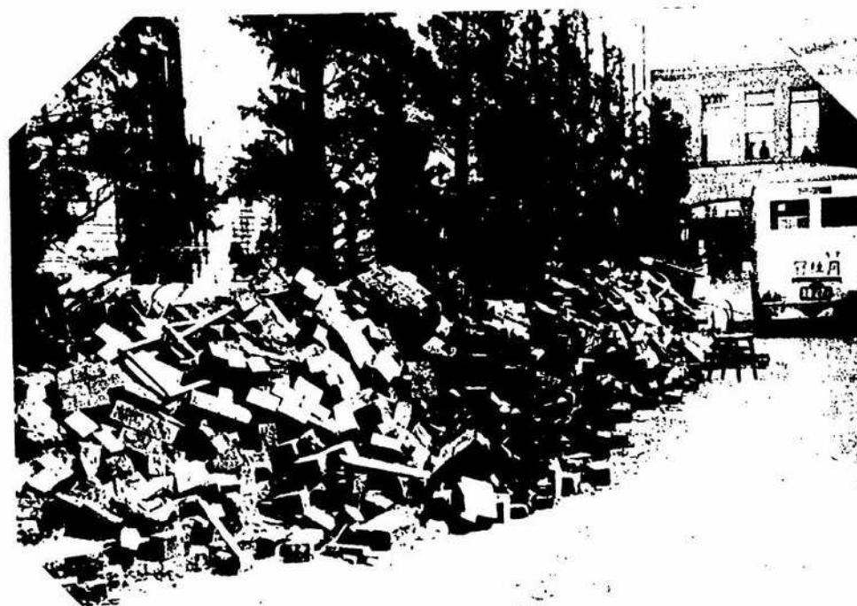
⇐ 大阪市港區九條大阪市電氣局前ニ流レ込メル木煉瓦ノ山 道路舗装ノ木煉瓦浸水ノ爲浮キ上リ押流サレタルモノ（減水後ノ狀況）
