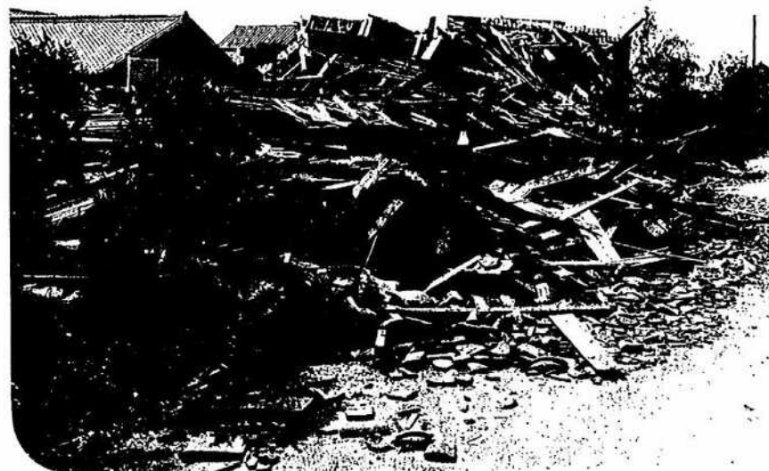
南河内郡金岡小學校ノ倒壊 暴風警報ニ依リ警戒中危険トナリ百 名ハ役場北側ニ三百名ハ南校舎廊下 ニ避難ス二階建二百坪講堂六十七 坪倒壊
