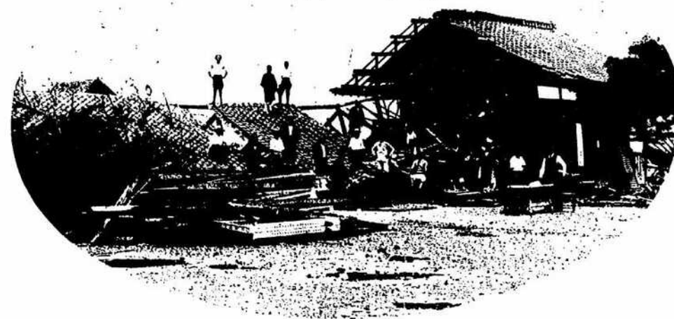
南河内郡新堂小學校ノ倒壊 十四教室校舎一種全壊セシガ僅カ二 分間ニシテ児童ヲ避難セシメ死傷者 ヲ出サズ
