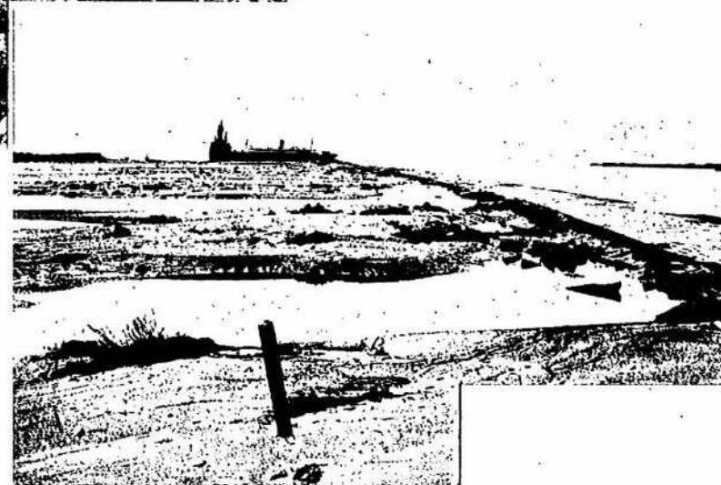
大阪市内淀川区外島町堤防決潰 コンクリート張ノ左側ニ堤防アリシ カ跡形モナク押流サル
