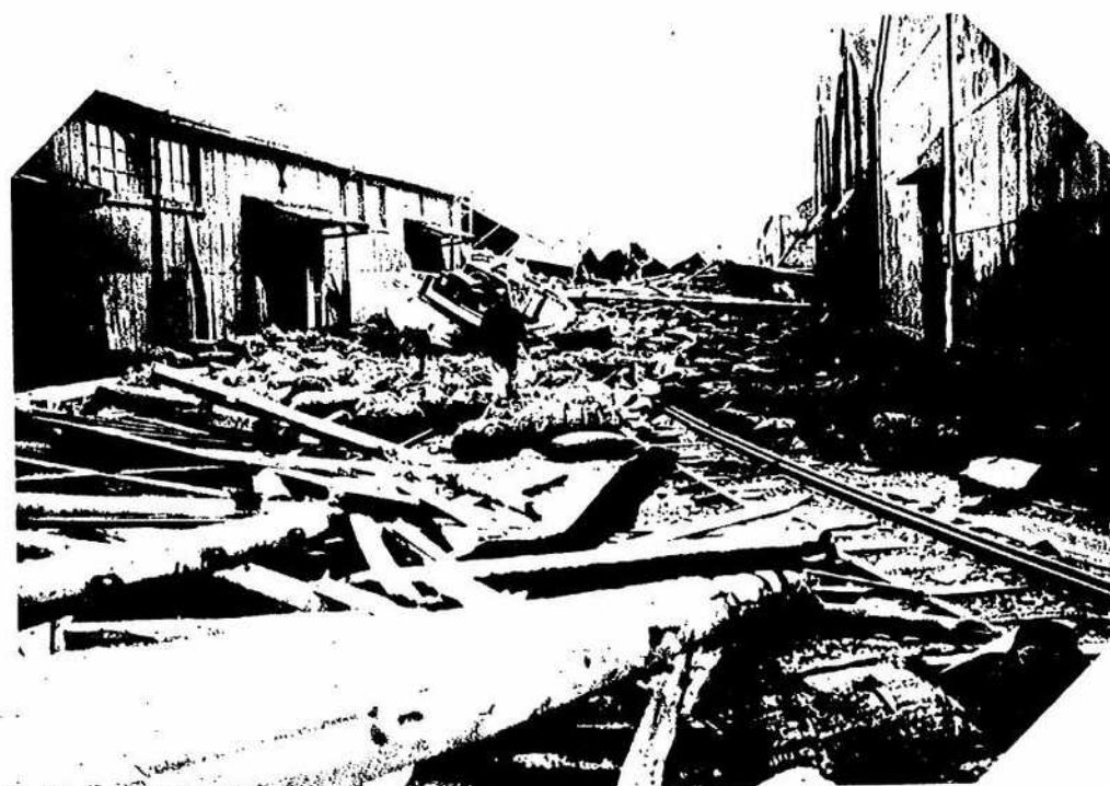
⇒ 大阪市港區築港附近倉庫地帯ノ浸水後ノ慘狀 倉庫内ニ收納中ノ玄米其ノ他在庫品損害夥シ 潮 高 倉庫内 八 尺
