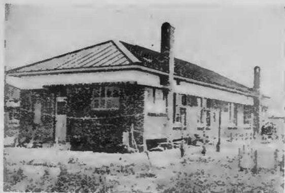
昭和25年度苫小牧製紙(株)工員住宅 アツシユ煉瓦造り耐火防寒構造
