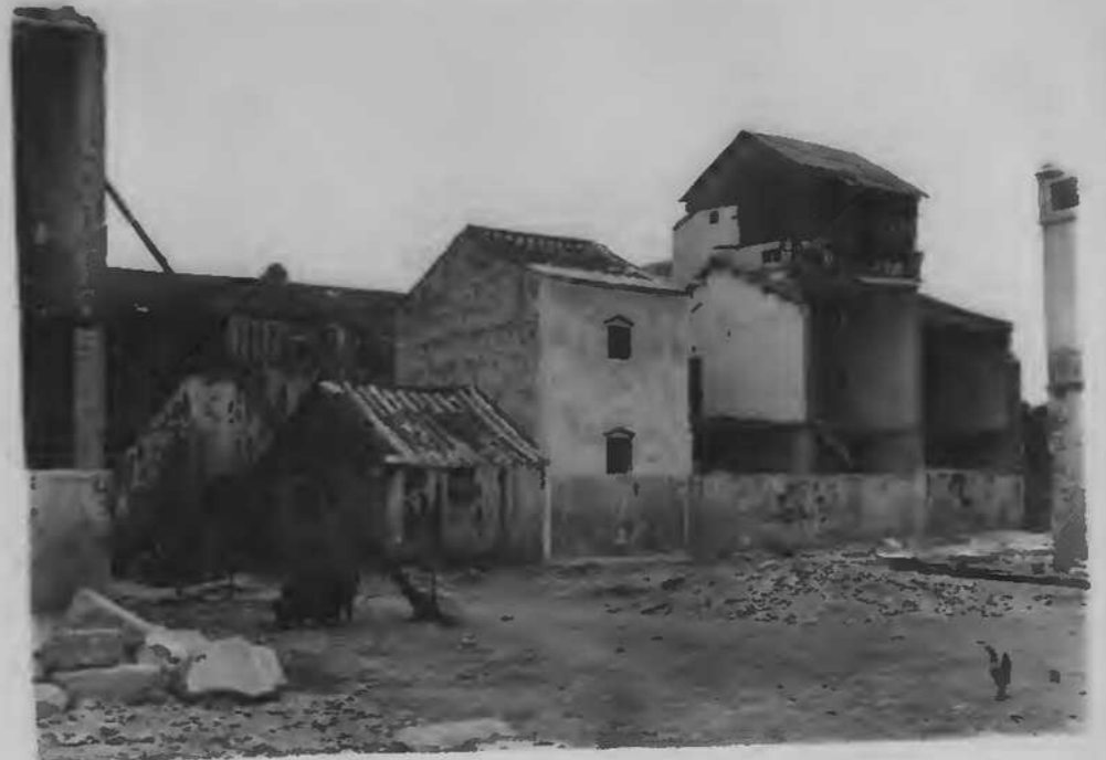
第一一四崎碌ノ一部 側壁(北面)ノ交叉壁ト分離 剪断倒壊セルモノ屋上ノ構 ノ如キハ竹造リナリ
