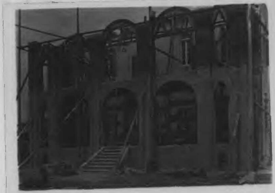
第十四圖 (崎碌) 修繕中ノ佛國領事館 △補強鉄棒ヲ挿入セルヲ 示ス
